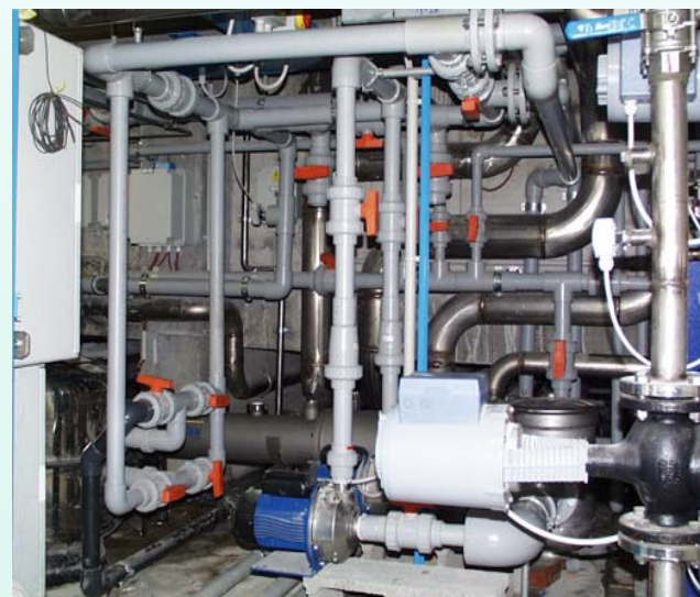
Трубопроводы термальных вод (сероводород)
