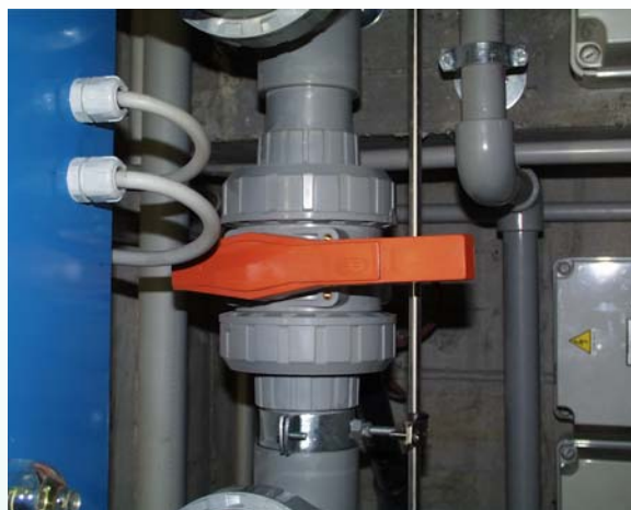
Трубопроводы термальных вод (сероводород)
